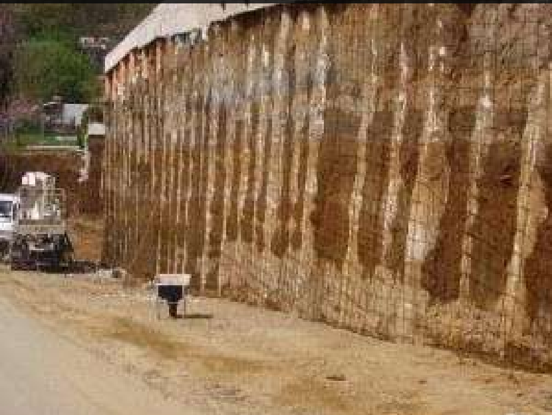
01 · PREPARAZIONE E ARMATURA
